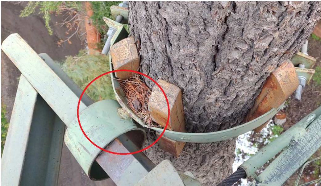
Imagen 10: Unión de anillos en extremo de la pasarela.
